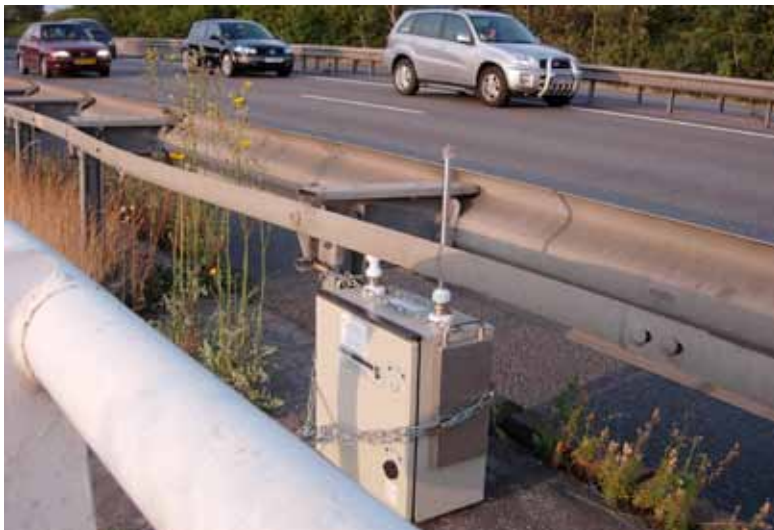
Abb. 2. Messstation Krakelshaff an der A3 in Fahrtrichtung Luxemburg Stadt.
